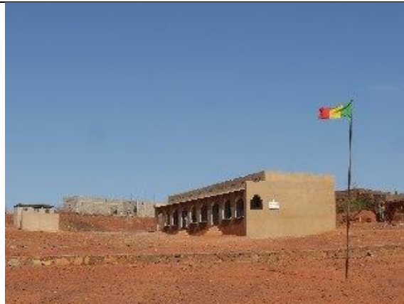
Sikoulou – das neue Gebäude der Grundschule
