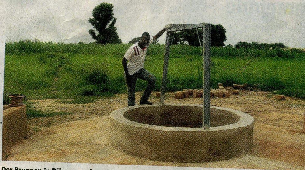
Der Brunnen in Djigue wurde mit professionellem Gerät erbaut. Er soll unter anderem der Bewässerung der angrenzenden Felder dienen.
