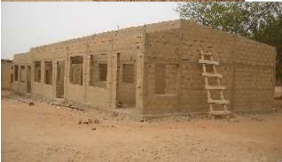
Bauarbeiten an der Schule in Djigue, Mitte April
